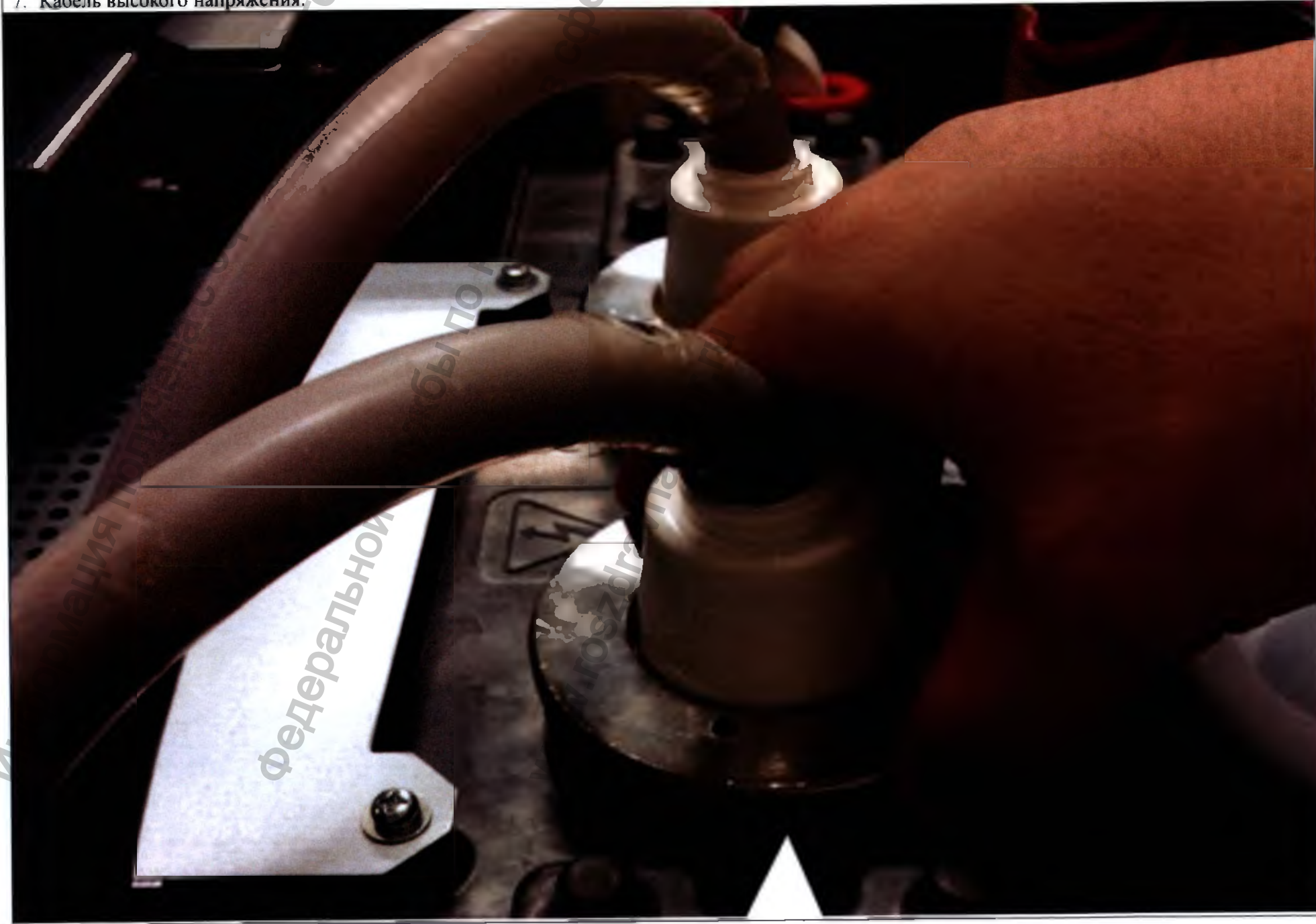
7. Кабель высокого напряжения.
