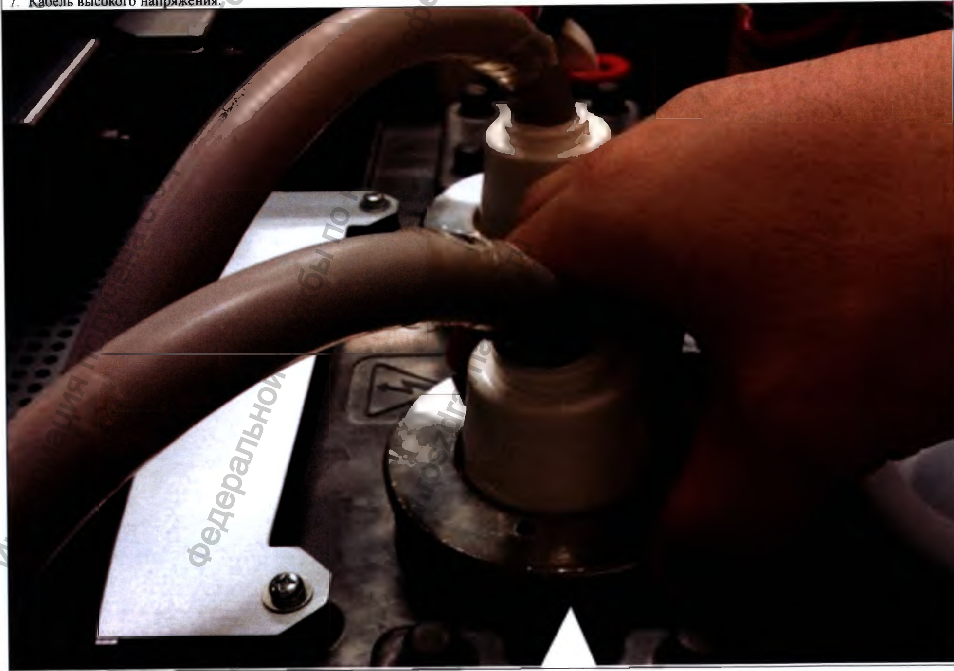
7. Кабель высокого напряжения.
